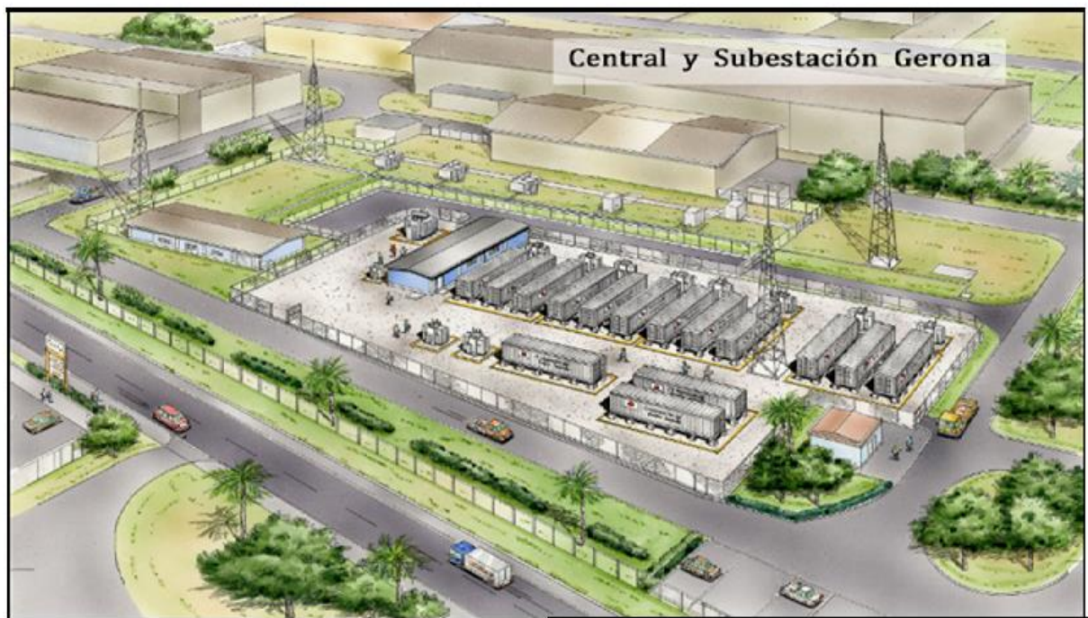
Figura 4 Subestación Gerona con vista a la incorporación del almacenamiento de energía
